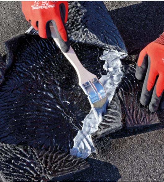
Bedingt durch Alterung, Witterungs- und Umwelteinflüsse sind Flachdächer häufig in Substanz und Funktion geschädigt. Versprödungen, Risse, Blasen, Falten und Undichtigkeiten in der Dachhaut erfordern Reparatur- oder grundlegende Sanierungsmaßnahmen. Wird ein Flachdach undicht, ist in der Regel eine zweite Dachhaut die einfachste und kostengünstigste Lösung, ohne dass die alte Dachoberfläche abgerissen werden muss.
