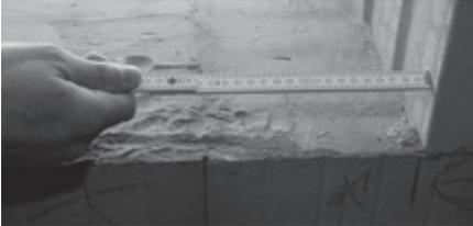
3. Fensterrahmenbautiefe und maximale Fugenbreite des Fensteranschlusses ermitteln.
